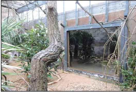
Madera forrada con láminas de metal/ malla de alambre
