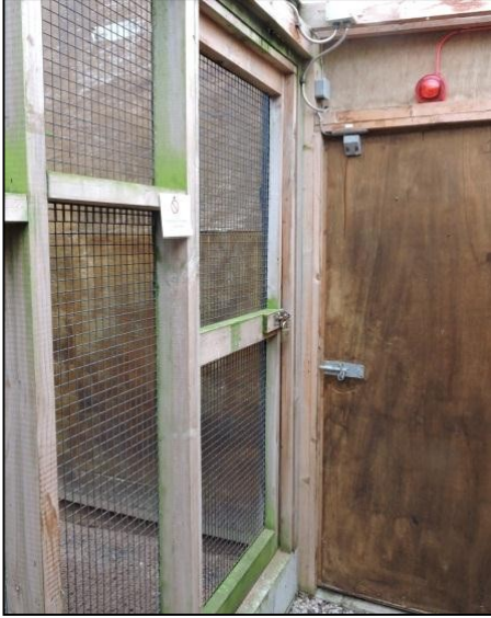
Una entrada segura es esencial prevenir escapes
